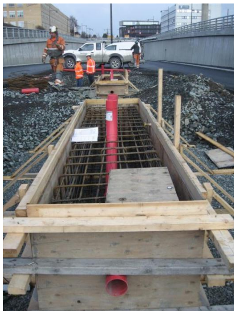
Príprava betónových základov pre priechod CADO
