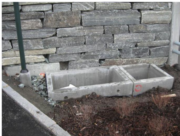
Základ pre kontrolný panel
